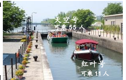
中岛闸门 (水上电梯)
